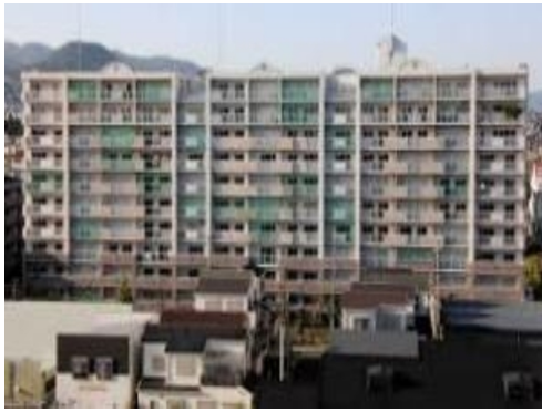
西宮市内の借上げ復興住宅
